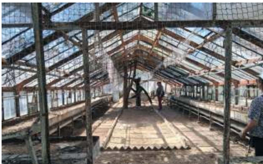
Le chantier des petites serres, première phase d'un projet global
