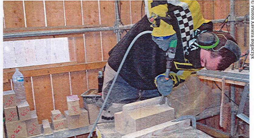
Noé taille la pierre à l'aide d'un ciseau plat monté sur un pistolet pneumatique. Un outil permettant d'aller plus vite.
